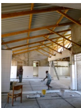
Neues Bäckereigebäude in der Ausbauphase
